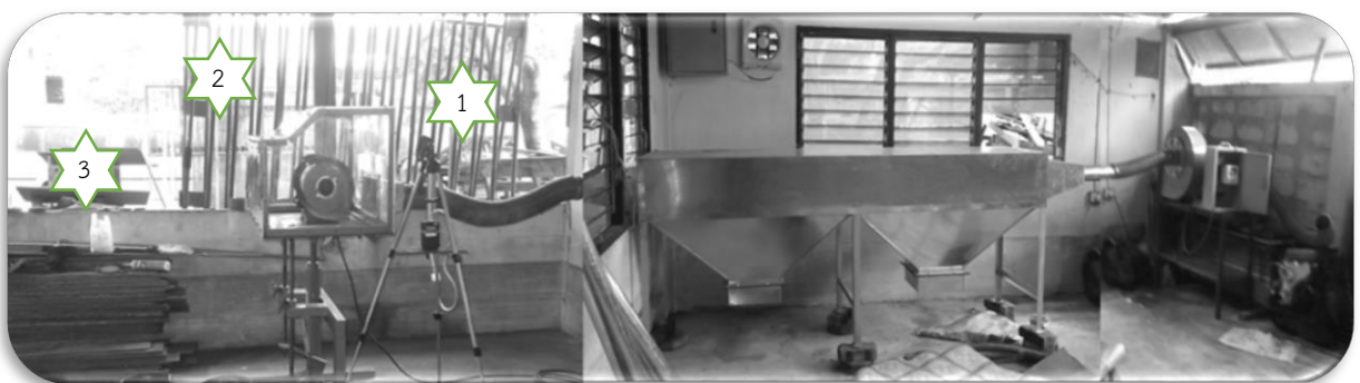
รูปที่2: แสดงระบบระบายอากาศที่ออกแบบและจุดตรวจวัดรอบๆพื้นที่การทำงาน
